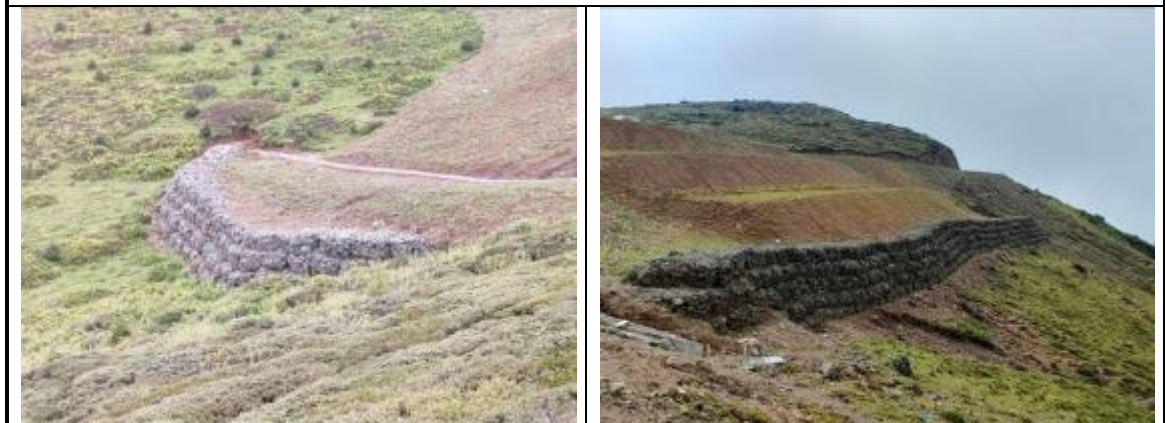
铅丝石笼挡渣墙（弃渣场区）
