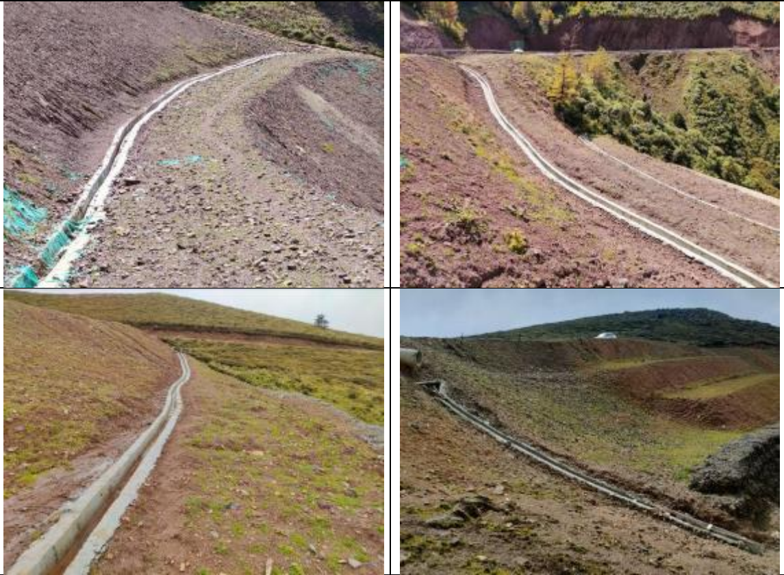
混凝土排水沟（弃渣场区）
