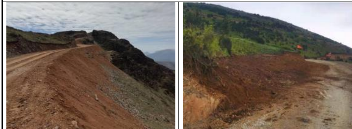
土地整治（道路工程区）
