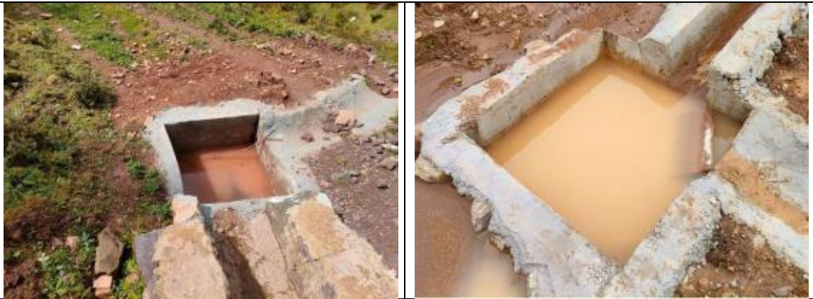
混凝土沉沙池（弃渣场区）
