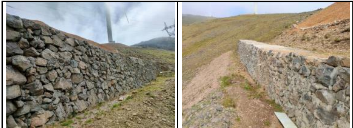
浆砌石挡渣墙（弃渣场区）
