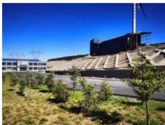
道路工程区斜坡防护工程
