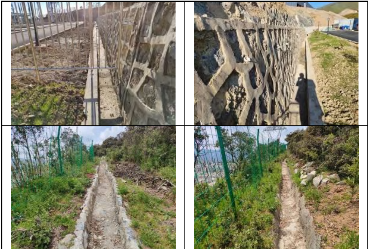
浆砌石排水沟（2021.7）
