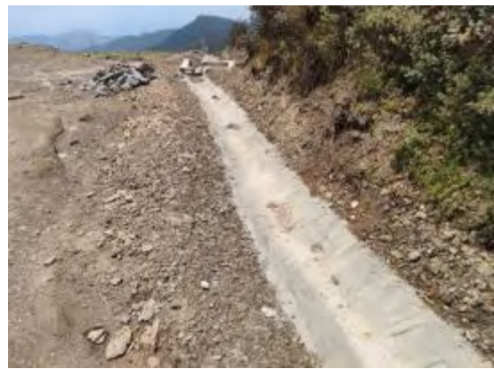
道路工程区防洪排导工程
