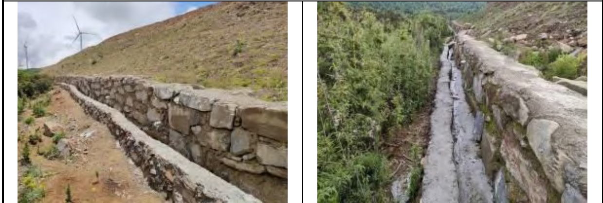
浆砌石挡渣墙（2021.7）
