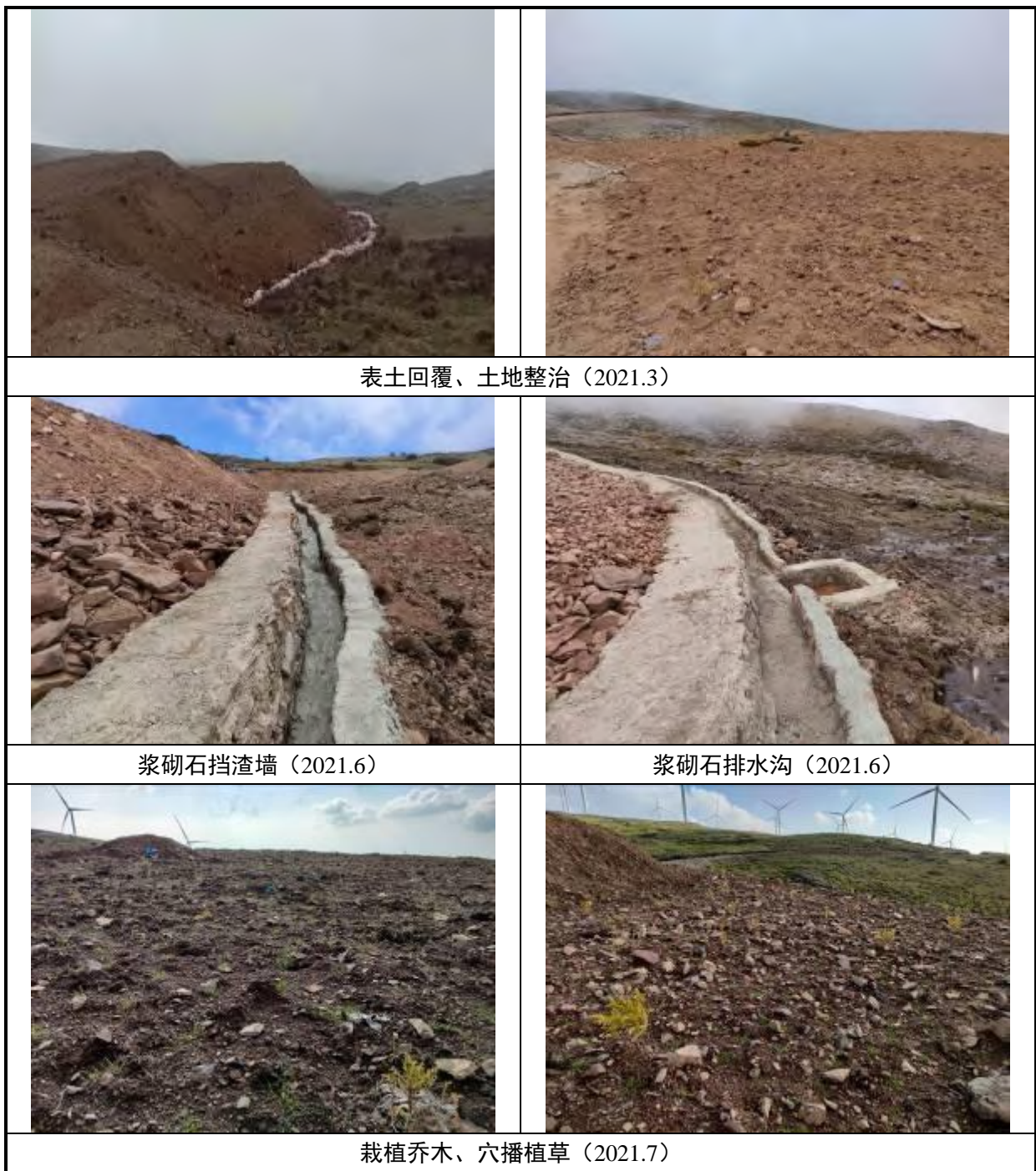
图 3-5 1#弃渣场水土保持措施现状图
