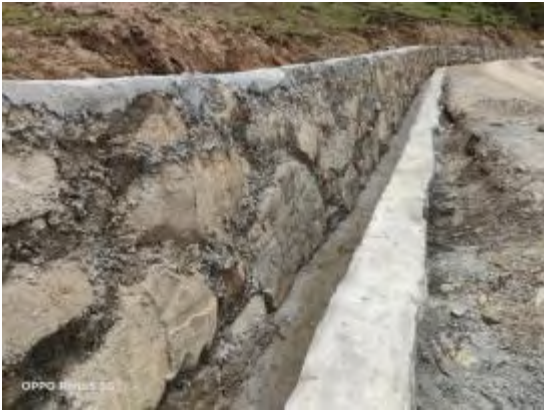
道路工程区防洪排导工程
