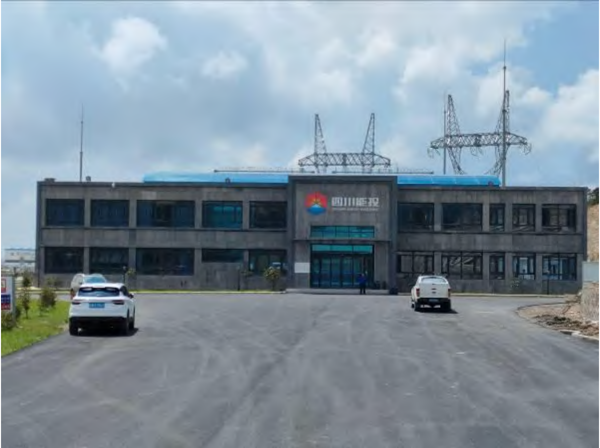
图 1.1-4 井叶特西 220kV 升压站
