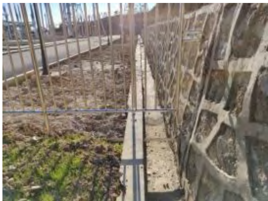
升压站工程区防洪排导工程
