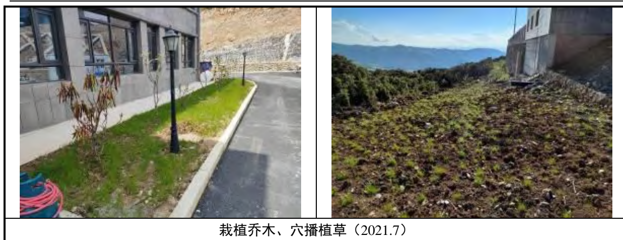
图 3-2 升压站工程区水土保持措施现状图
