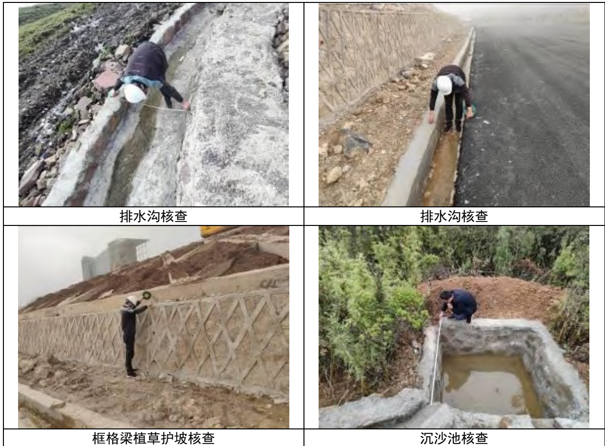
图 4-2 工程措施核查情况
