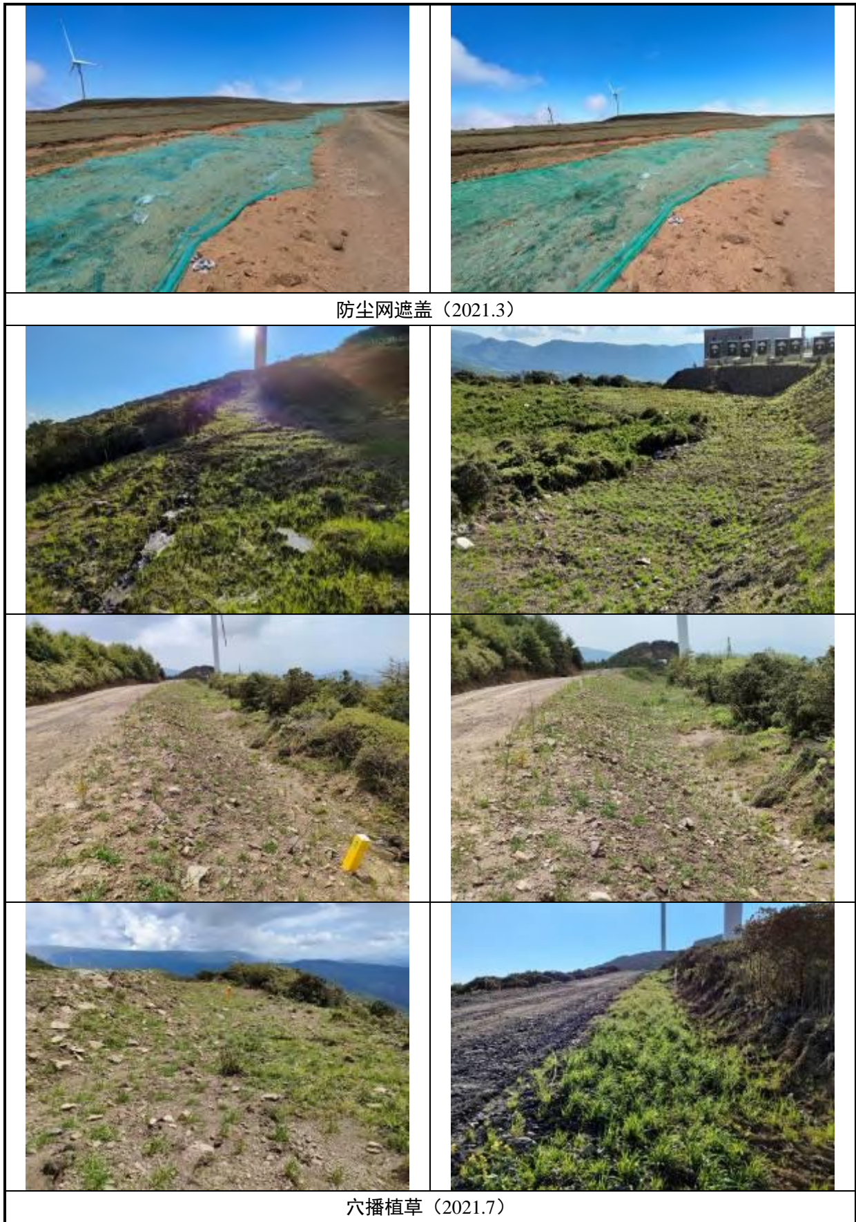
图 3-1 集电线路工程区水土保持措施现状图
