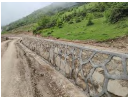
道路工程区斜坡防护工程
