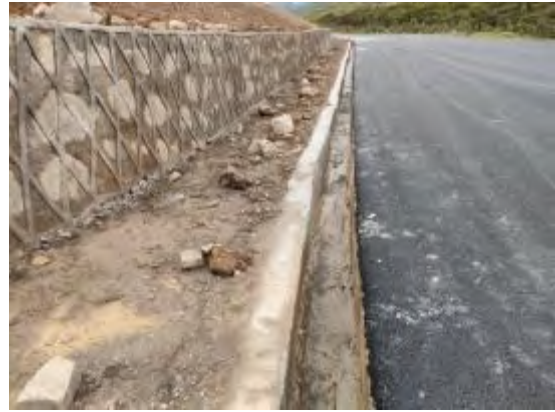
道路工程区防洪排导工程
