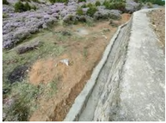
弃渣场工程区拦渣、防洪排导工程
